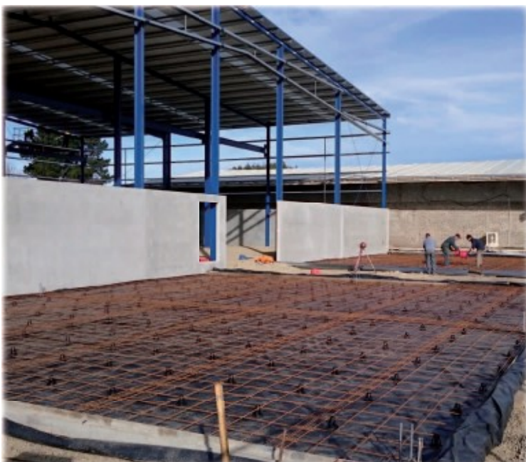
Floor prepared for concrete pour
