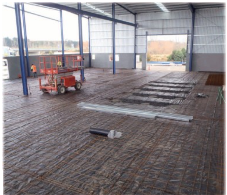
Floor prepared for concrete pour
