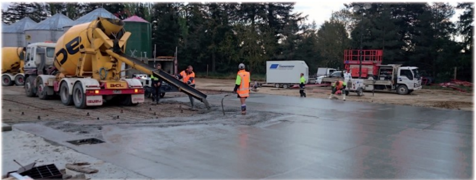
Concrete pour in progress
